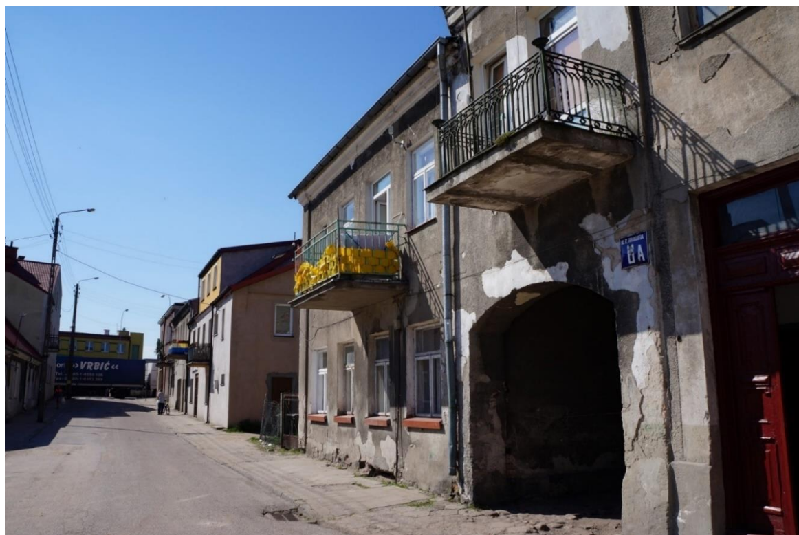
FOT. 5. ZABUDOWA MIESZKALNA PRZY UL. TRAUGUTTA
