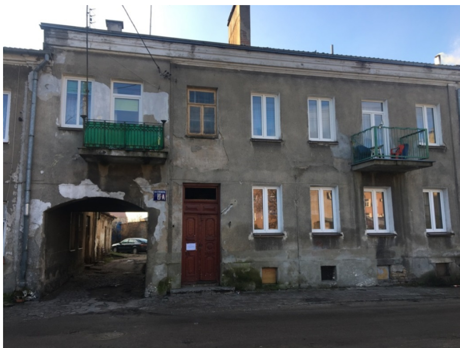
Fot. 1. Elewacja wschodnia – frontowa uszkodzenia tynku, zawilgocenia cokołu, przebarwienia na całej powierzchni elewacji.
