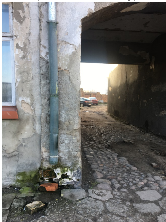
Fot. 2. Elewacja wschodnia – uszkodzenia cokołu przy rurze spustowej, rozwój porostów w strefie cokołowej.
