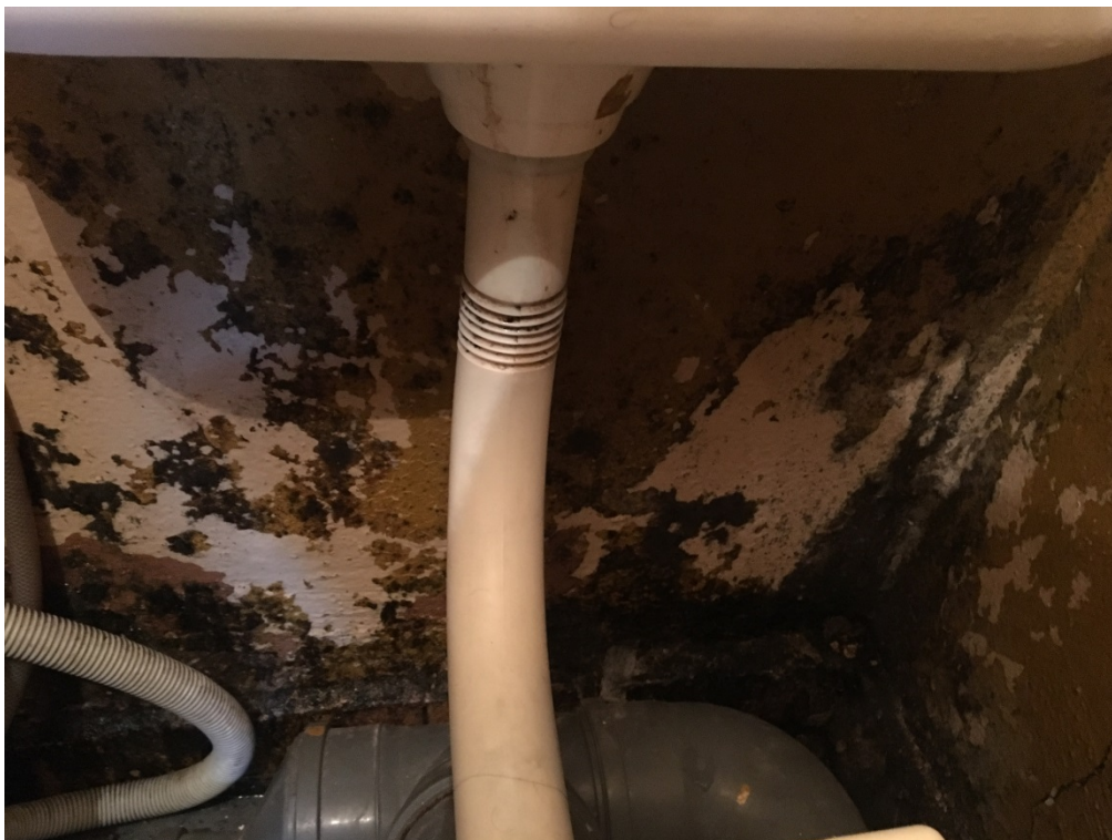
Fot. 21. Lokal mieszkalny nr 4 - ściana w łazience, rozwój grzybów pleśniowych.
