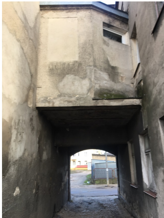
Fot. 14. Elewacja zachodnia – brama - uszkodzenia i przebarwienia tynku, rozwój porostów.
