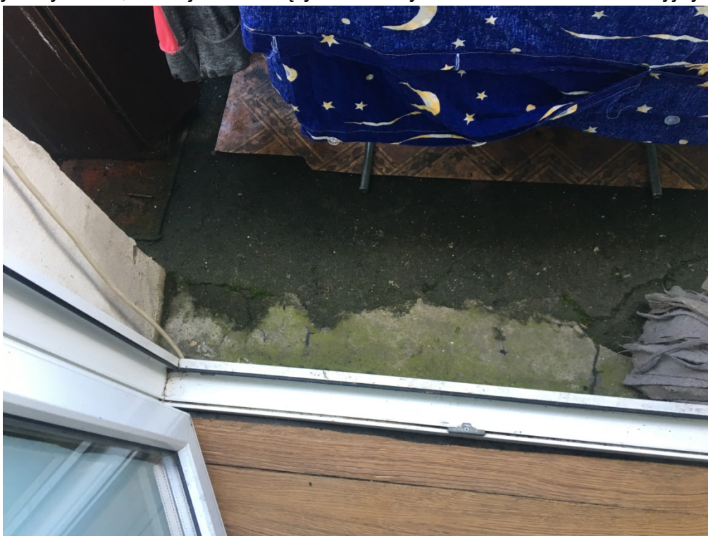
Fot. 4. Elewacja wschodnia – spękanieposadzki żelbetowej płyty balkonu, brak skutecznej hydroizolacji.
