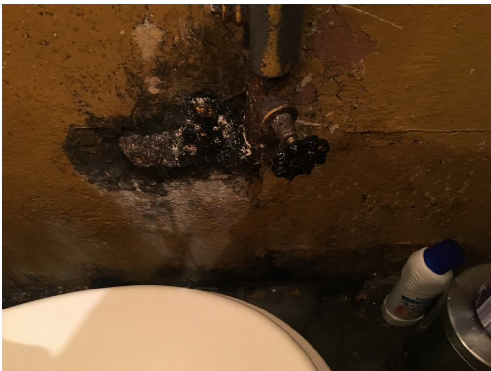
Fot. 20. Lokal mieszkalny nr 4 - ściana w łazience, rozwój grzybów pleśniowych.
