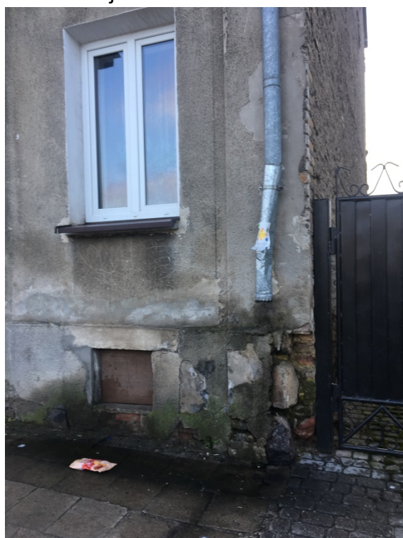
Fot. 12. Elewacja wschodnia – uszkodzenia cokołu przy urwanej rurze pustawej, rozwój porostów w strefie cokołowej.
