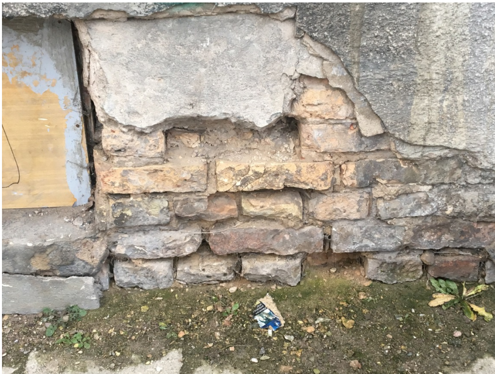
Fot. 10. Elewacja wschodnia – zniszczenia w strefie cokołu, wykruszone spoiny, uszkodzenia cegły pełnej, zawilgocenia, rozwój porostów.
