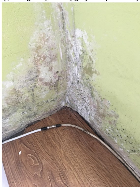
Fot. 24. Lokal mieszkalny nr 4– zawilgocenia w strefie przypodłogowej, rozwój grzybów pleśniowych.
