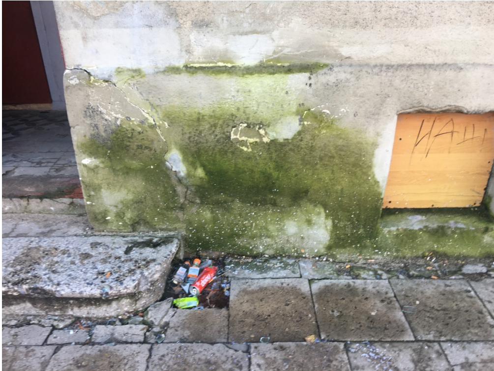
Fot. 9. Elewacja wschodnia – zniszczenia w strefie cokołu, zawilgocenia, rozwój porostów.
