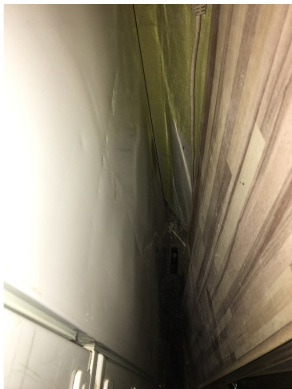
Fot. 23. Lokal mieszkalny nr 4– zawilgocenia w strefie przypodłogowej, rozwój grzybów pleśniowych.
