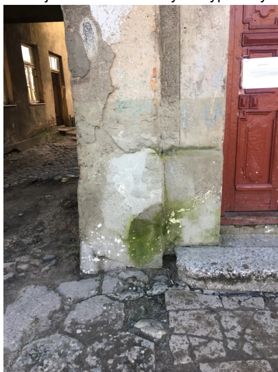
Fot. 8. Elewacja wschodnia – zniszczenia w strefie cokołu, zawilgocenia, rozwój porostów.
