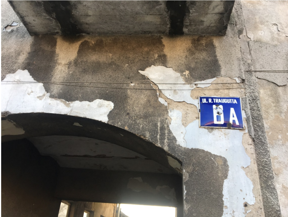
Fot. 5. Elewacja wschodnia – uszkodzenia tynku pod balkonem, nad bramą wjazdową.
