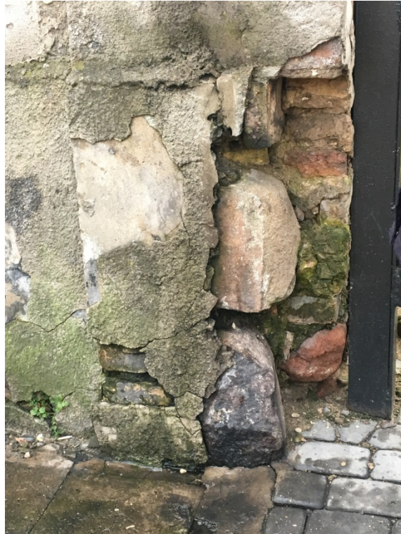
Fot. 13. Elewacja wschodnia – uszkodzenia cokołu przy urwanej rurze spustowej, rozwój porostów w strefie cokołowej.
