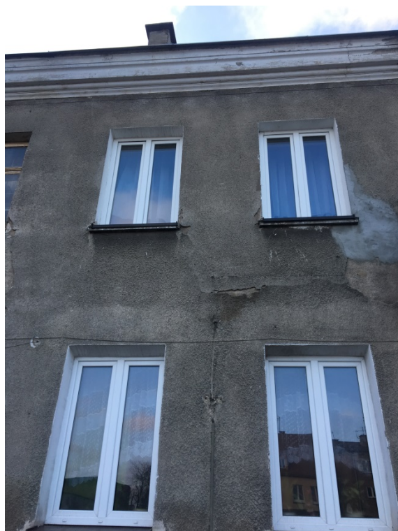
Fot. 11. Elewacja wschodnia – uszkodzenia tynku.
