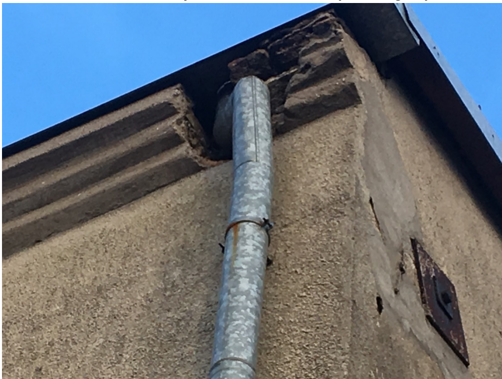
Fot. 16. Elewacja zachodnia – połączenie rynny z rurą spustową, uszkodzenia gzymsu.
