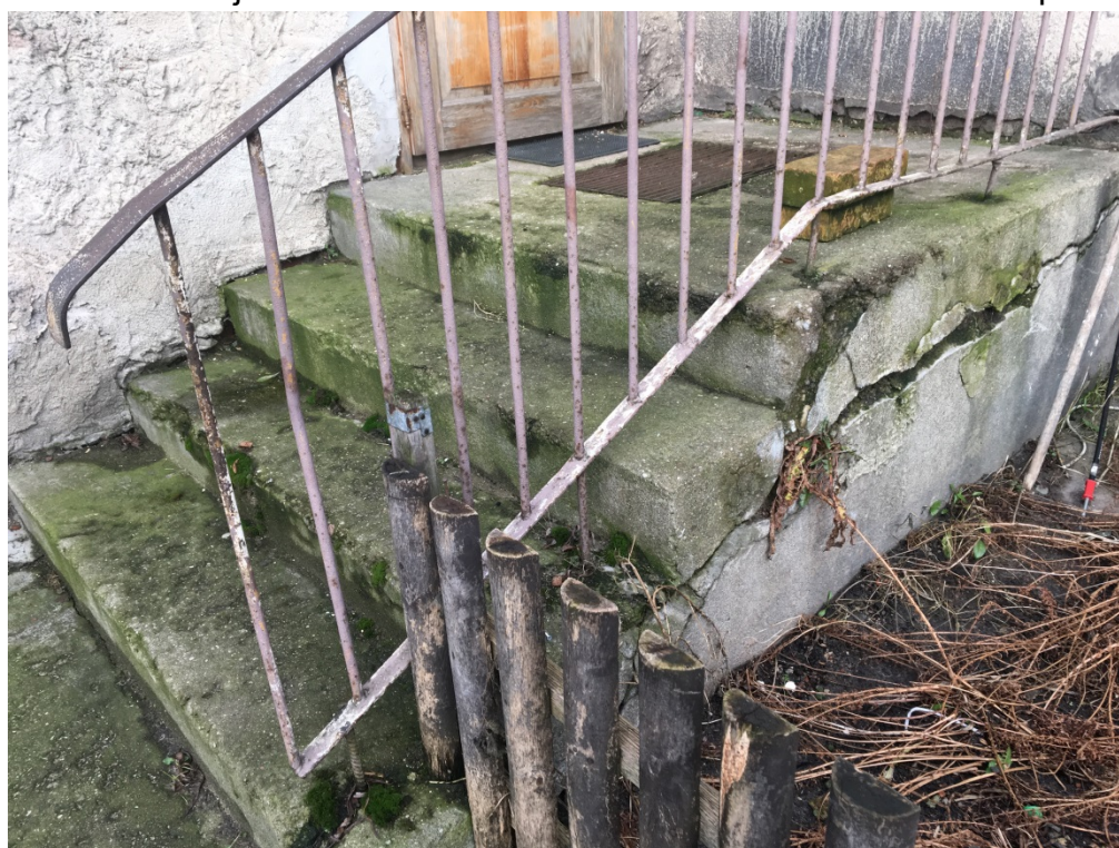
Fot. 18. Elewacja zachodnia – uszkodzenia schodów do przybudówki.
