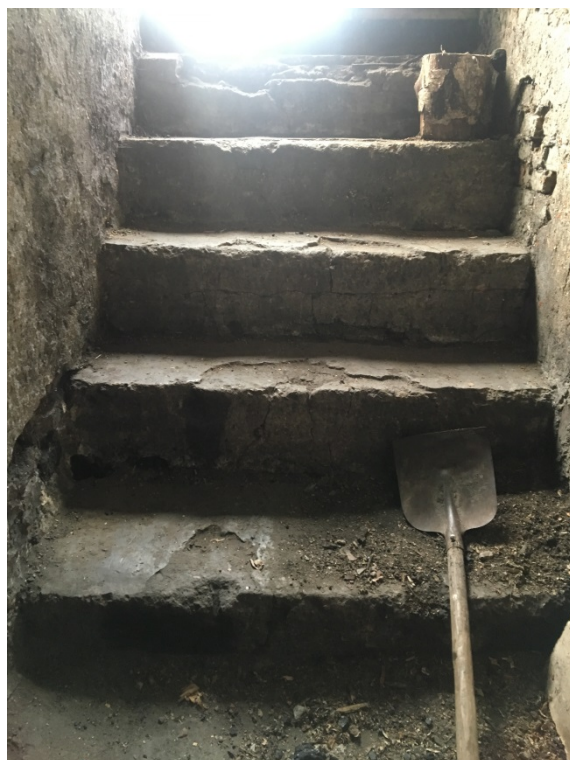
Fot. 17. Elewacja zachodnia – uszkodzenia schodów do kotłowni i piwnic.
