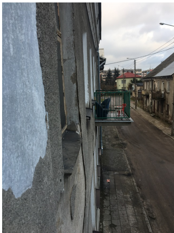
Fot. 7. Elewacja wschodnia – ubytki wypraw tynkarskich.
