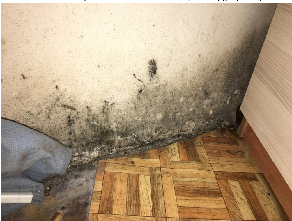
Fot. 22. Lokal mieszkalny nr 4 – zawilgocenia w strefie przypodłogowej, rozwój grzybów pleśniowych.
