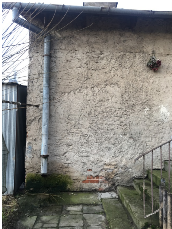
Fot. 19. Elewacja zachodnia – uszkodzenia schodów do przybudówki, zawilgocenia przy rurze spustowej, rozwój mchów i porostów.
