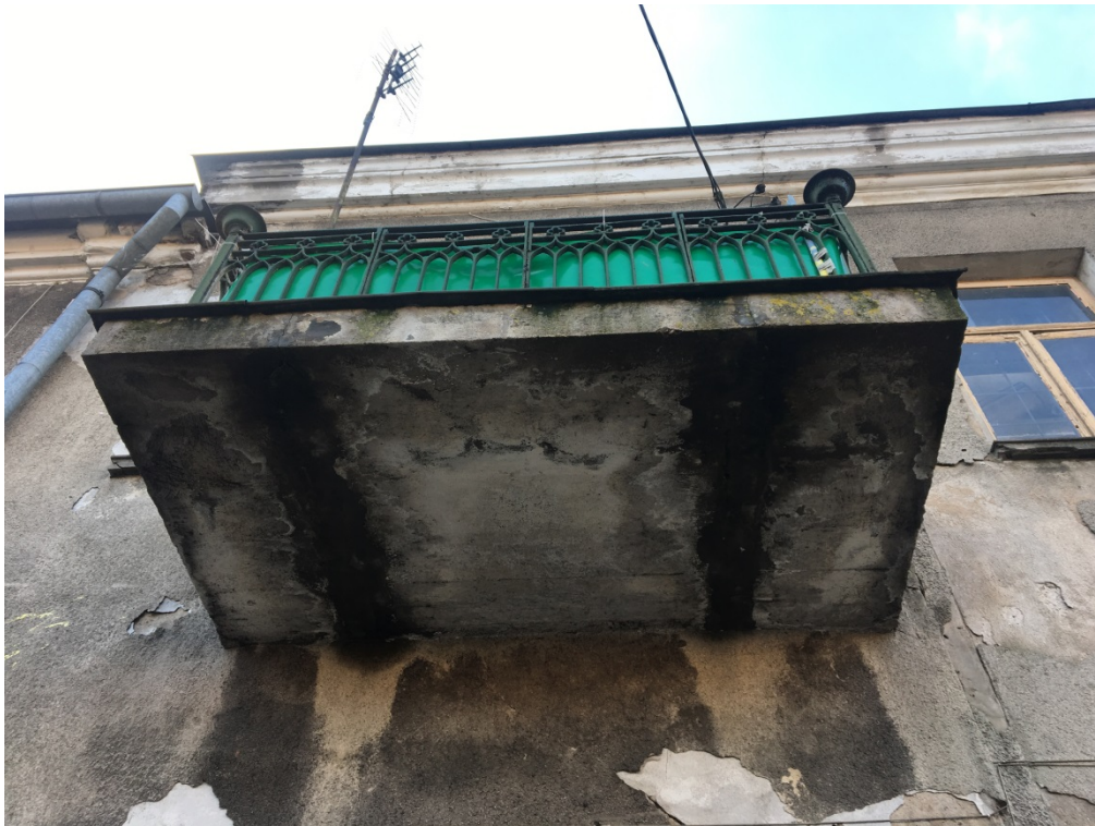
Fot. 3. Elewacja wschodnia – uszkodzenia żelbetowej płyty balkonu, wykwity solne, korozja odsłoniętych stalowych elementów konstrukcyjnych.
