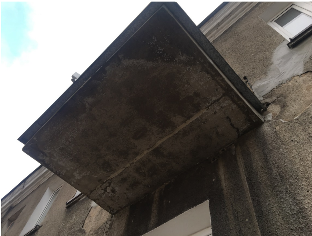
Fot. 6. Elewacja wschodnia – uszkodzenia żelbetowej płyty drugiego balkonu, wykwity solne, spękania płyty.
