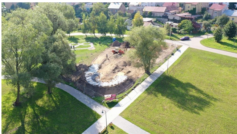
Budowa pumptracku na terenie Parku Solidarności w Grajewie
