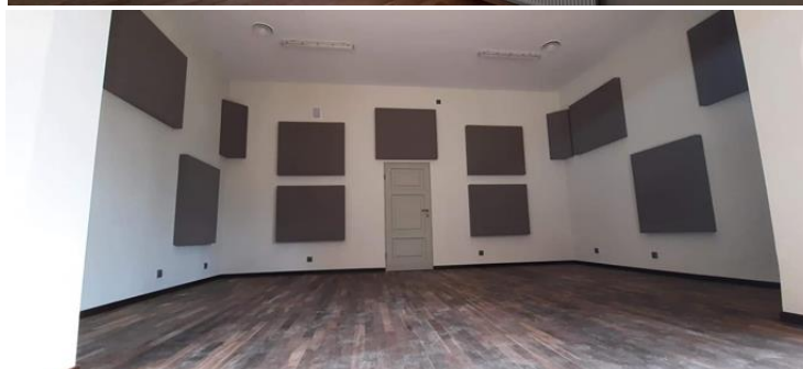
Remont Klubu „Hades” (wymiana stolarki okiennej, prace remontowe)
