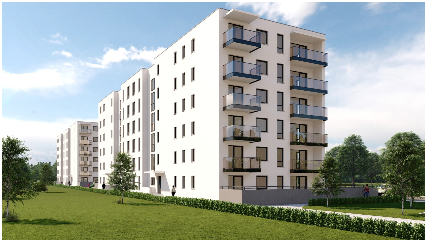
WIDOK 1 od strony północno-zachodniej
