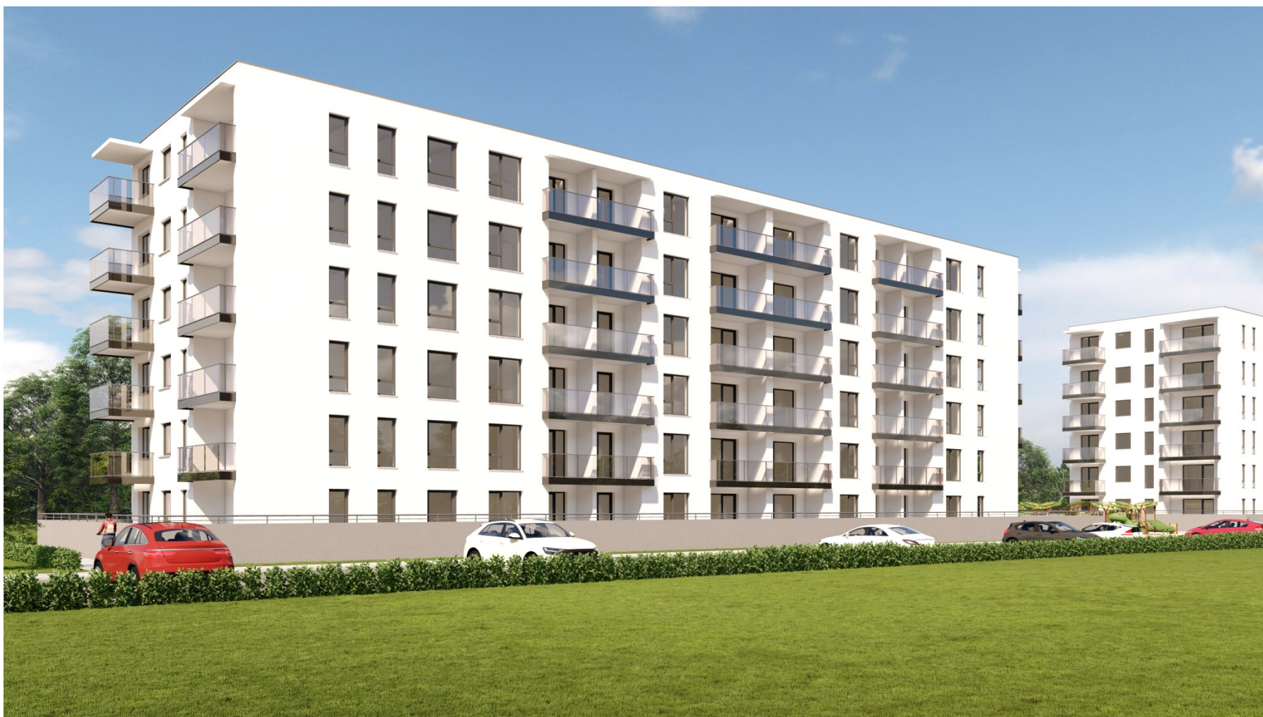
WIDOK 1 od strony południowej
